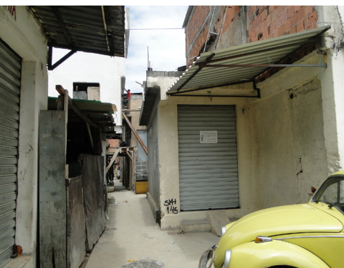
▲ Complexo do Alemão: interior da favela com vielas estreitas e construções precárias
